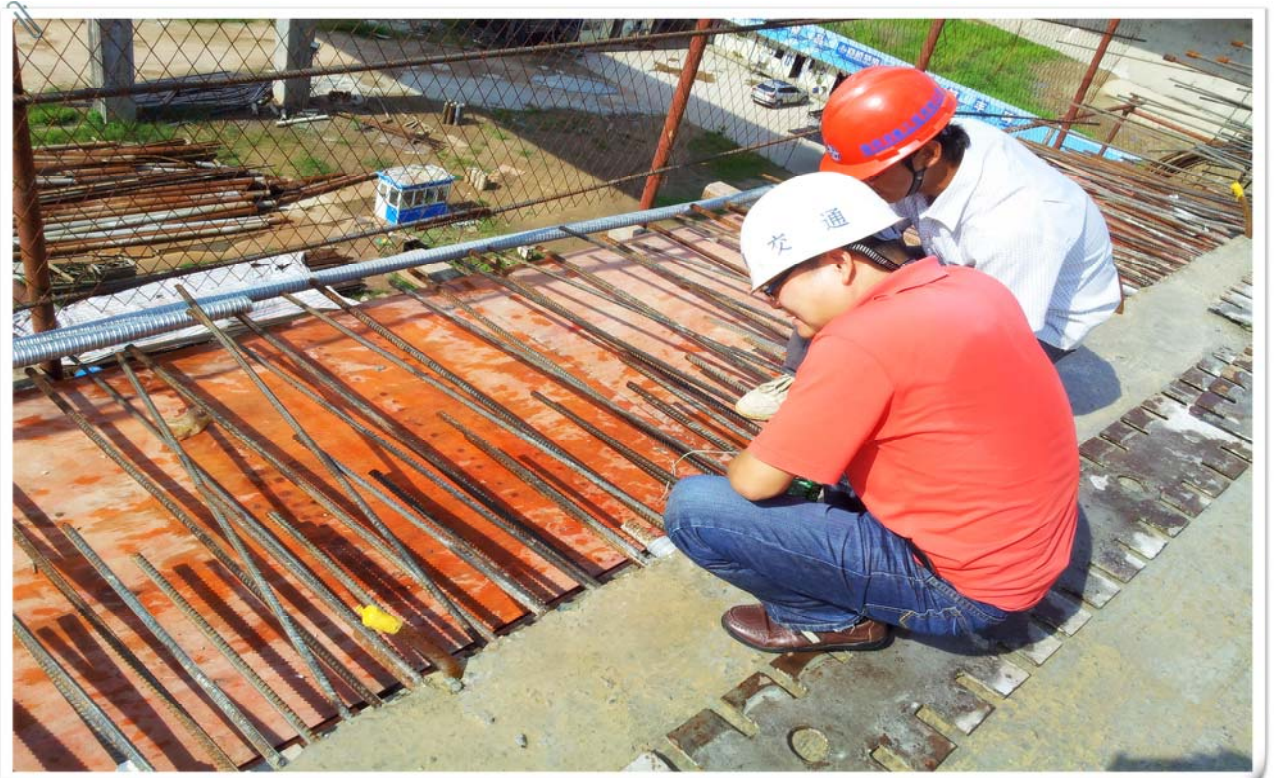
■市质监站进行建材产品摸排工作现场
